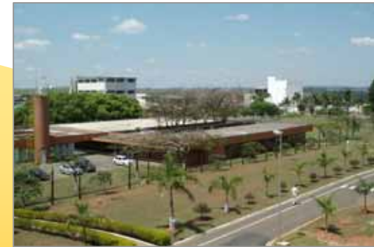
リメイラ工場
