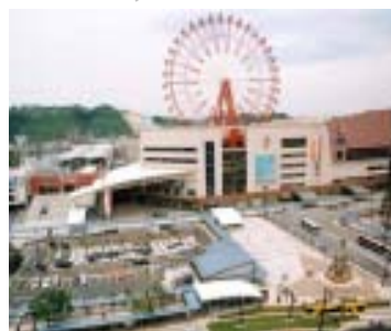
[Arredores da estação Kagoshima-Chuo]
